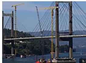
Una de las grúas rebasa la altura de pilar norte del puente de Rande
